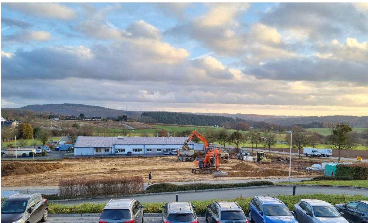
Aufnahme der Erdarbeiten des neuen Firmengrundstücks
