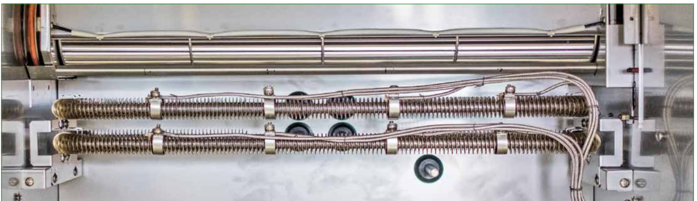
Rohrrippenheizung mit Oberflächentemperaturüberwachung und -begrenzung
